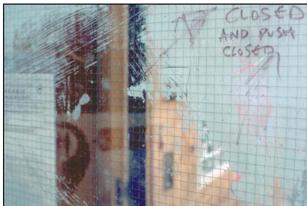
Рис. 1.27. Краска, надпись и арматурная проволока оказывают влияние на прозрачность этой стеклянной панели
