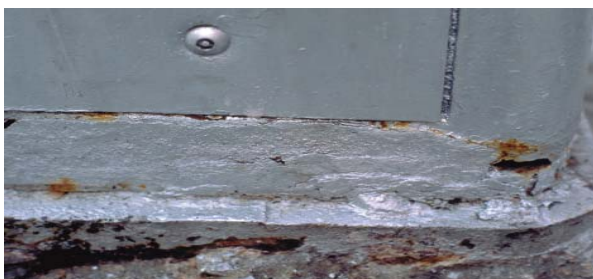
Рис. 1.10. Ржавчина позволяет судить о материале основания этого фонарного столба
