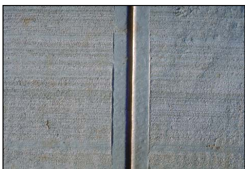
Бетон: уложенный бетоном тротуар
