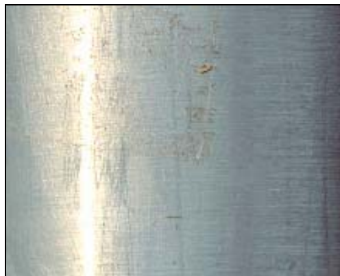
Изношенный металл: очищенная щеткой сталь
